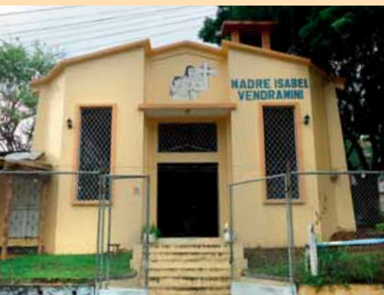
Contributo della comunità per riparare il tetto della cappella (Ecuador).
